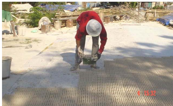
ภาพที่ 36 การทำดินดอกหรือดินตุ้ม
