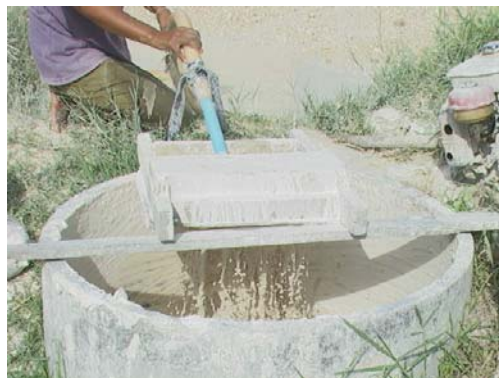
ภาพที่ 28 การกรองน้ำดินผ่านตะแกรงลงในบ่อกรอง
